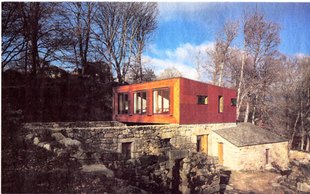
Dans la vallée de l'Aubrac : la surélévation en bois s'appuie sur les vieilles pierres d'une ancienne grange. Cabinet d'architectes Bical-Courcier-Martinelli. ARNAUD SAINT-GERMES/ARNAUD BICAL
