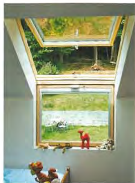
Voilà une astuce pour conserver la vision sur l'extérieur et maximiser l'entrée de lumière lorsqu'une ouverture de toit rencontre une fenêtre.
