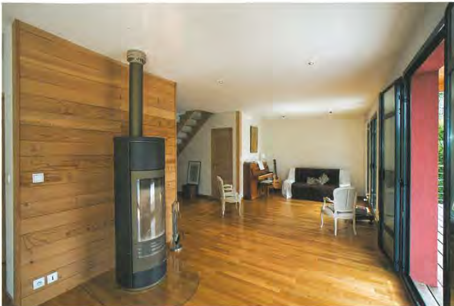
L'emplacement du poêle permet de chauffer aisément le rez-de-chaussée. Sa proximité avec la trémie de l'escalier laisse la chaleur se propager graduellement vers le haut. Le poêle est adossé à un mur de cèdre de l'Atlantique (d'origine française). La chaleur a pour effet d'accroître le parfum de cette essence de bois et sa diffusion.
