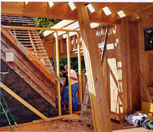
L'extension vient s'imbriquer dans l'habitation principale. De ce fait, un gros travail de modification de la charpente a dû être réalisé...
