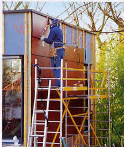
Les murs extérieurs sont constitués d'une ossature en bois. Un pare-pluie est posé sur des panneaux OSB (type Triply) avant de recevoir les plaques de parement.
