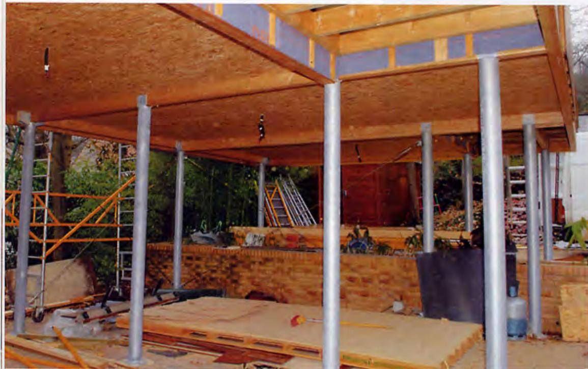
Première étape de construction : réaliser le plancher sur pilotis. Les poteaux sont en métal, ce qui allège visuellement la structure. Une laine de roche isole le plancher en bois.
