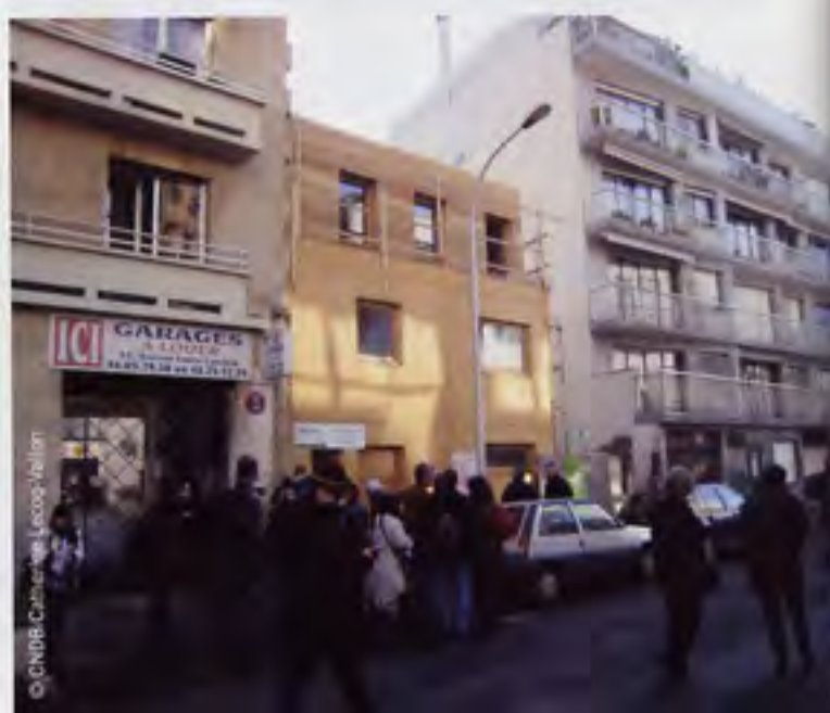
Maison située à Boulogne-Billancourt (92), faite de panneaux à ossature bois.
