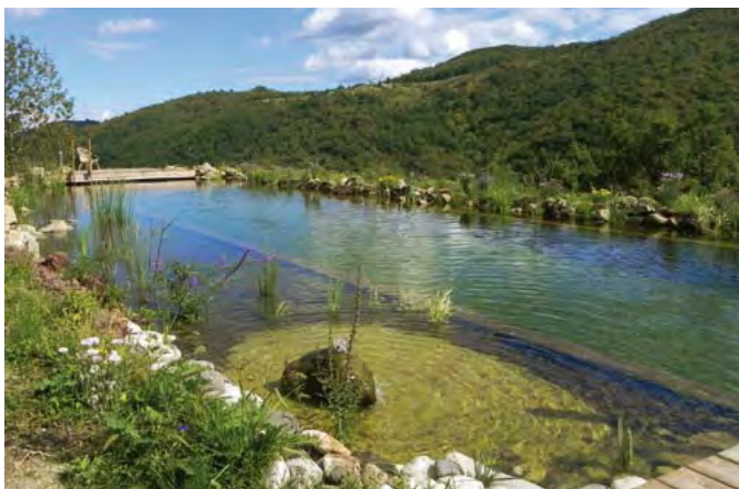
Ce bassin en mélèze au liner EPDM de 20 x 4 m a été réalisé par DO-MI-SI-LA .
